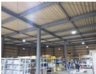
某所設備会社様 倉庫照明12台として、照明しています。
