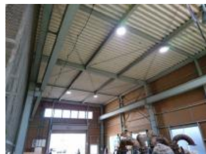
某所製造会社様 工場照明として10台で照明しています。
